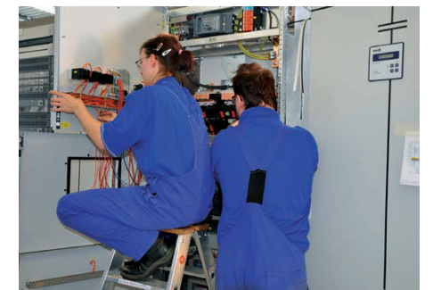
Montage einer Schaltanlage
