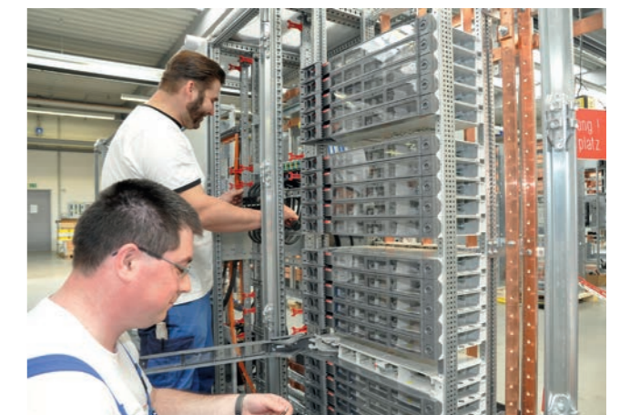
Montage einer Schaltanlage
