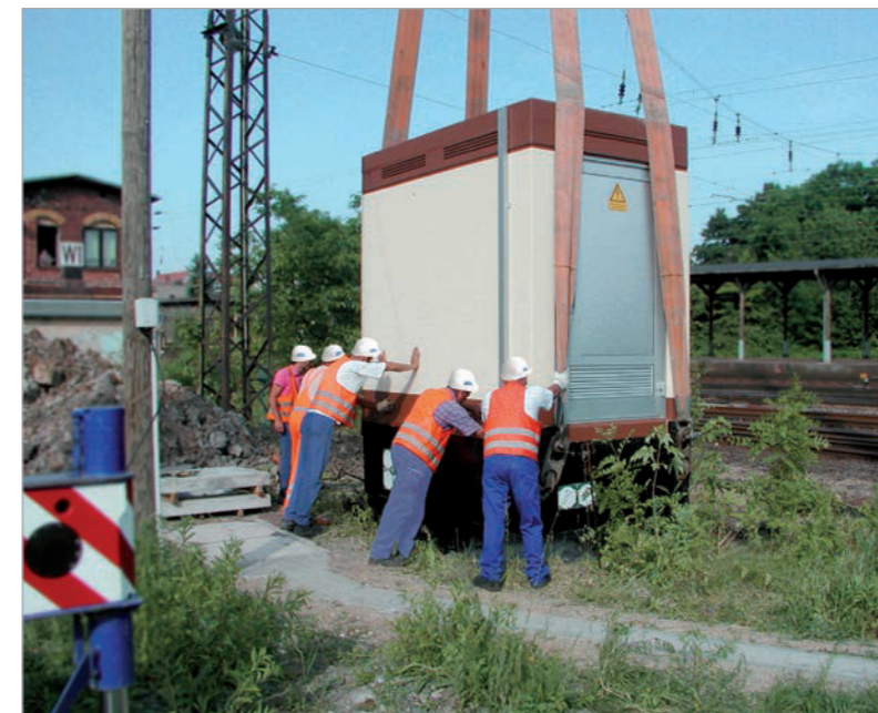
Eine Fertigteilbetonstation wird an ihren Einsatzort gesetzt
