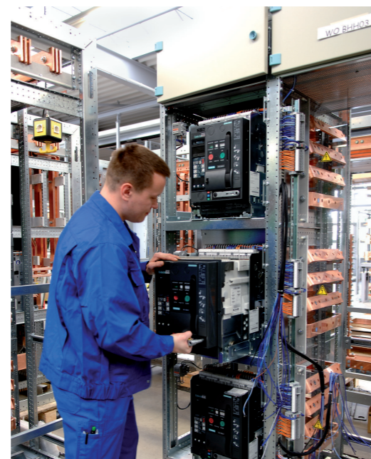
Montage einer Schaltanlage
